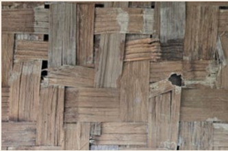
Anyaman bambu getas, patah dan anyaman renggang. Foto: Martinus S. Cahyono (2024).
