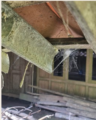
Sawang (sarang laba-laba) pada usuk bambu. Bambu terlihat muncul bubuk. Foto: Febriyanti S. (2025)
