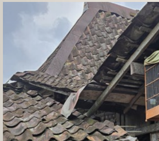
Lembaran seng berkarat pada bubungan atap dan talang datar pertemuan atap. Foto: Febriyanti S. (2025).
