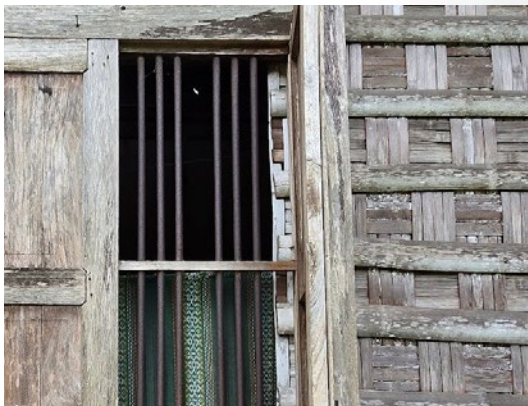
Logam berupa teralis besi dan pengunci jendela. Foto: Febriyanti S. (2025).
