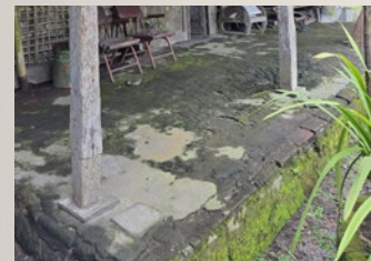
Lapisan lantai semen pecah, terkelupas dan berlumut. Photo: Febriyanti S. (2025).
