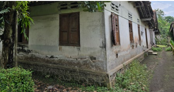
Dinding bata, diplester dan dicat pada Omah Jawa 'Mbuduran memperlihatkan jejak lembab pada bagian bawah. Foto: Febriyanti S. (2025).
