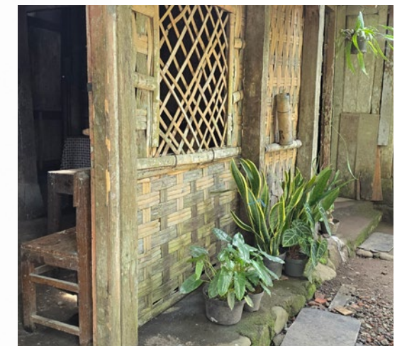
Pagar (dinding) gedhek (anyaman bambu), jendela bambu dan usuk bambu. Foto: Febriyanti S. (2025).
