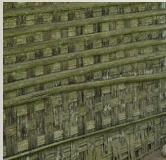
Lumut pada dinding gedhek . Foto: Febriyanti S. (2025).
