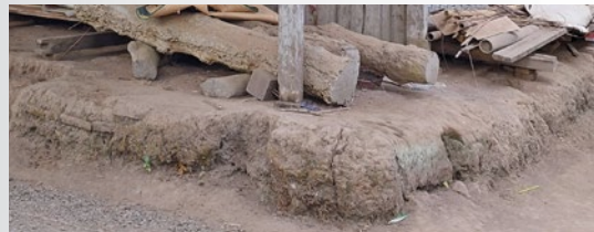
Batur tanah pada Omah Jawa 'Mbuduran. Foto: Febriyanti S. (2025).
