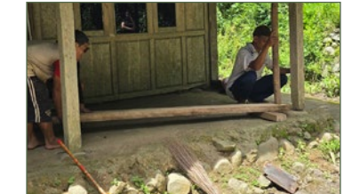
Perbaikan saka (tiang) kayu dengan cara diantru (diungkit).
